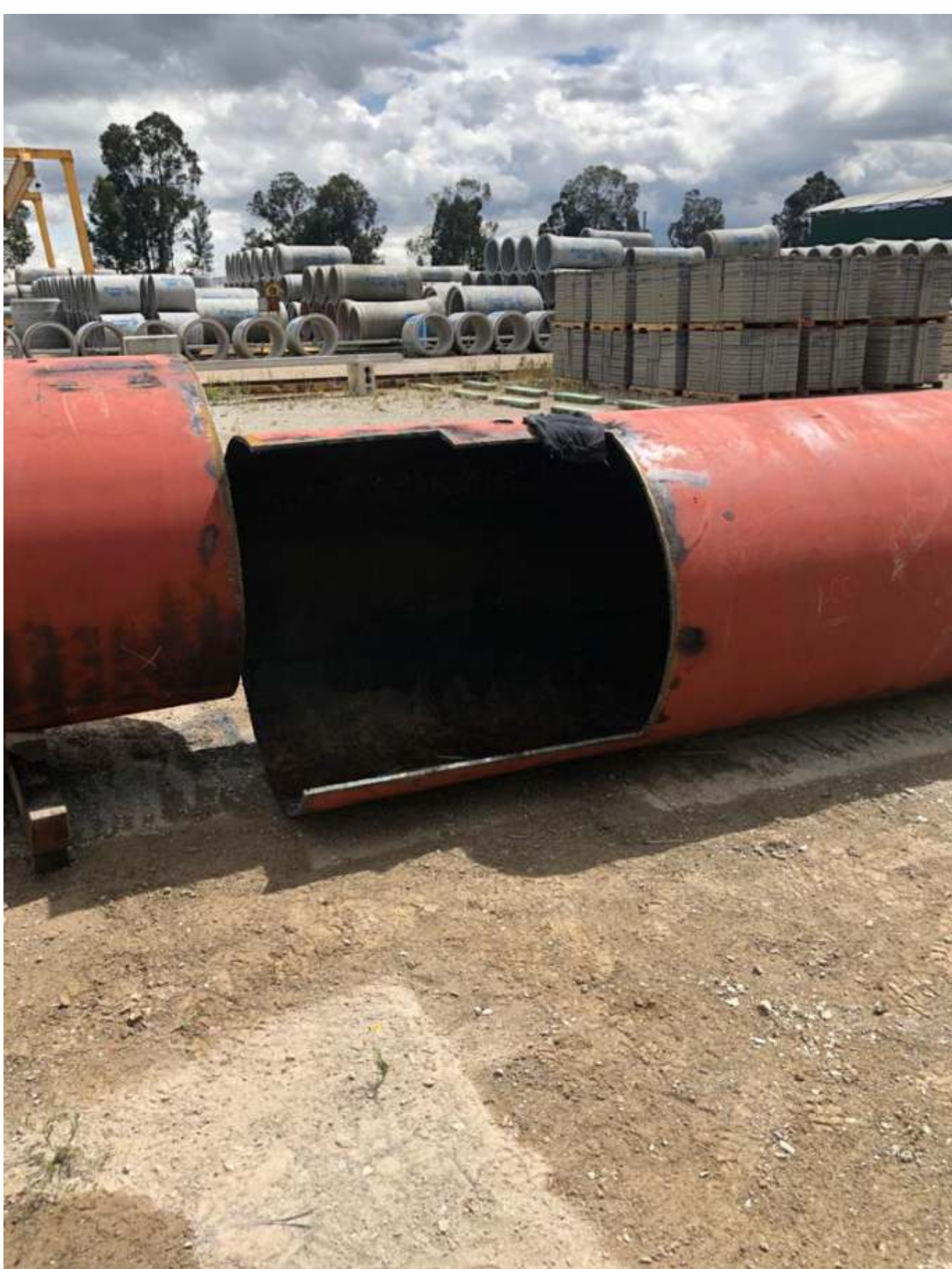
Corte de Tubo de Ø42” 9 metros
