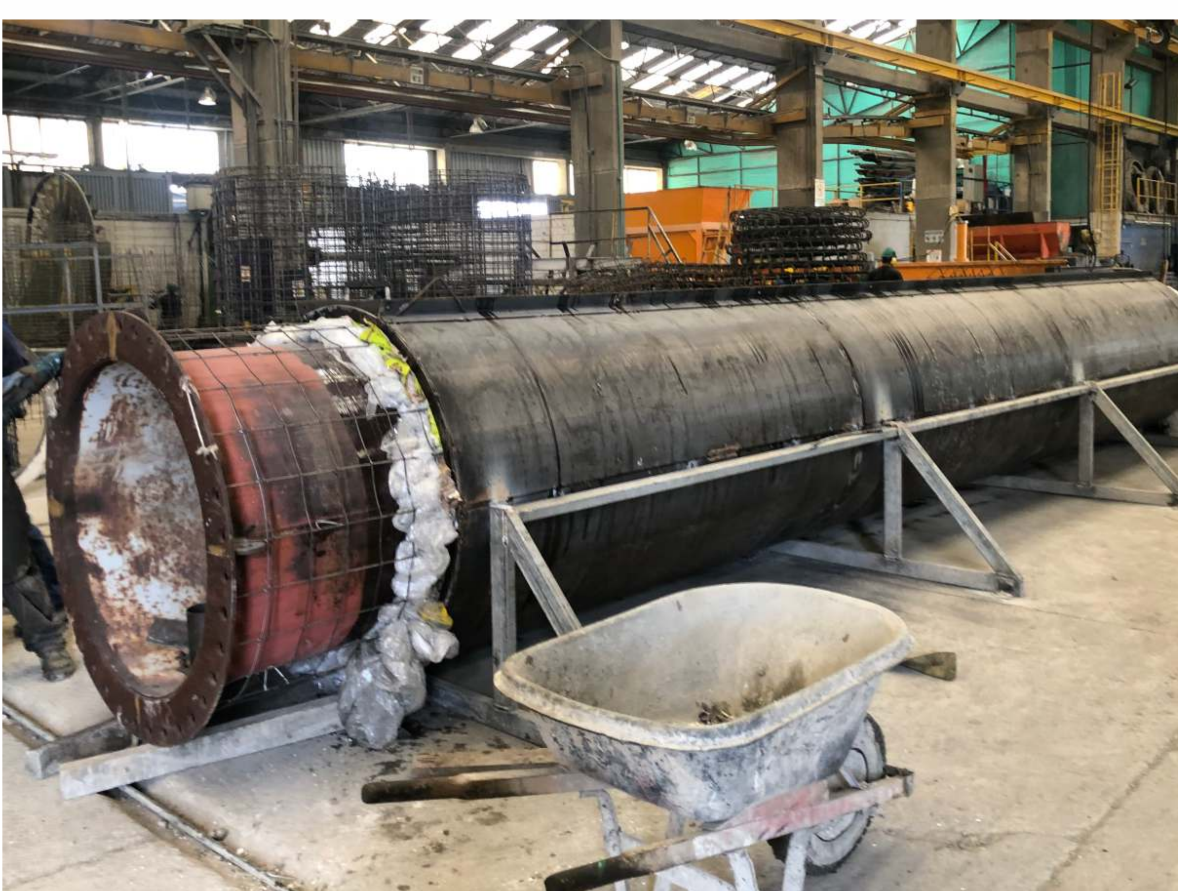
Lastrado de 12.5cm de concreto a tubo
